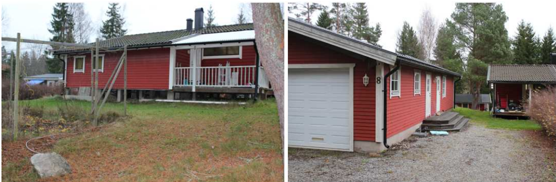
Figur 5.6c. Fastighet 3:55 bostadshus (vänster) och garage (höger), Foto: AFRY
