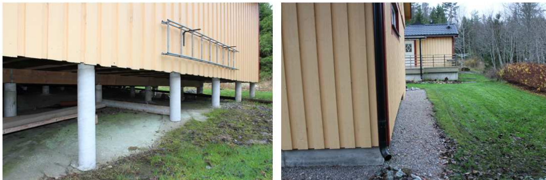
Figur 5.5b. Fastighet 3:94 bostadshus är grundlagt på plintar direkt på berg (vänster) och grundläggning av garage (höger), Foto: AFRY
