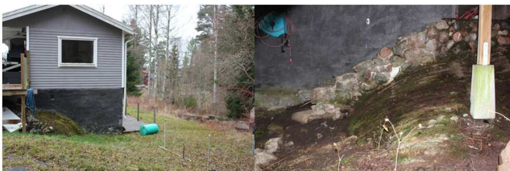
Figur 5.9d. Fastighet 3:20 bostadshus från öster (vänster) och grund under trädäck från väster (höger), Foto: AFRY
