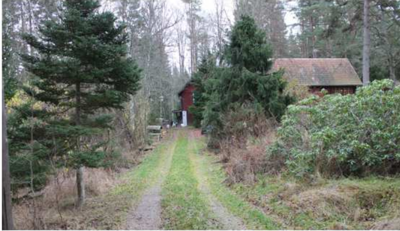
Figur 5.7b. Fastighet 3:177 garage (vänster) och bostadshus (höger), Foto: AFRY
